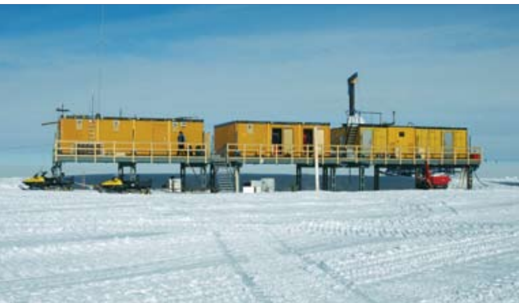
Forskningsstationen Kohnen var base for den 2500 meter dybe fælleseuropæiske EPICA-boring i Dronning Maud Land. Stationen balancerer på stylder, der ved hjælp af donkraftte hæver bygningerne en halv meter om året, så den ikke sner til.
